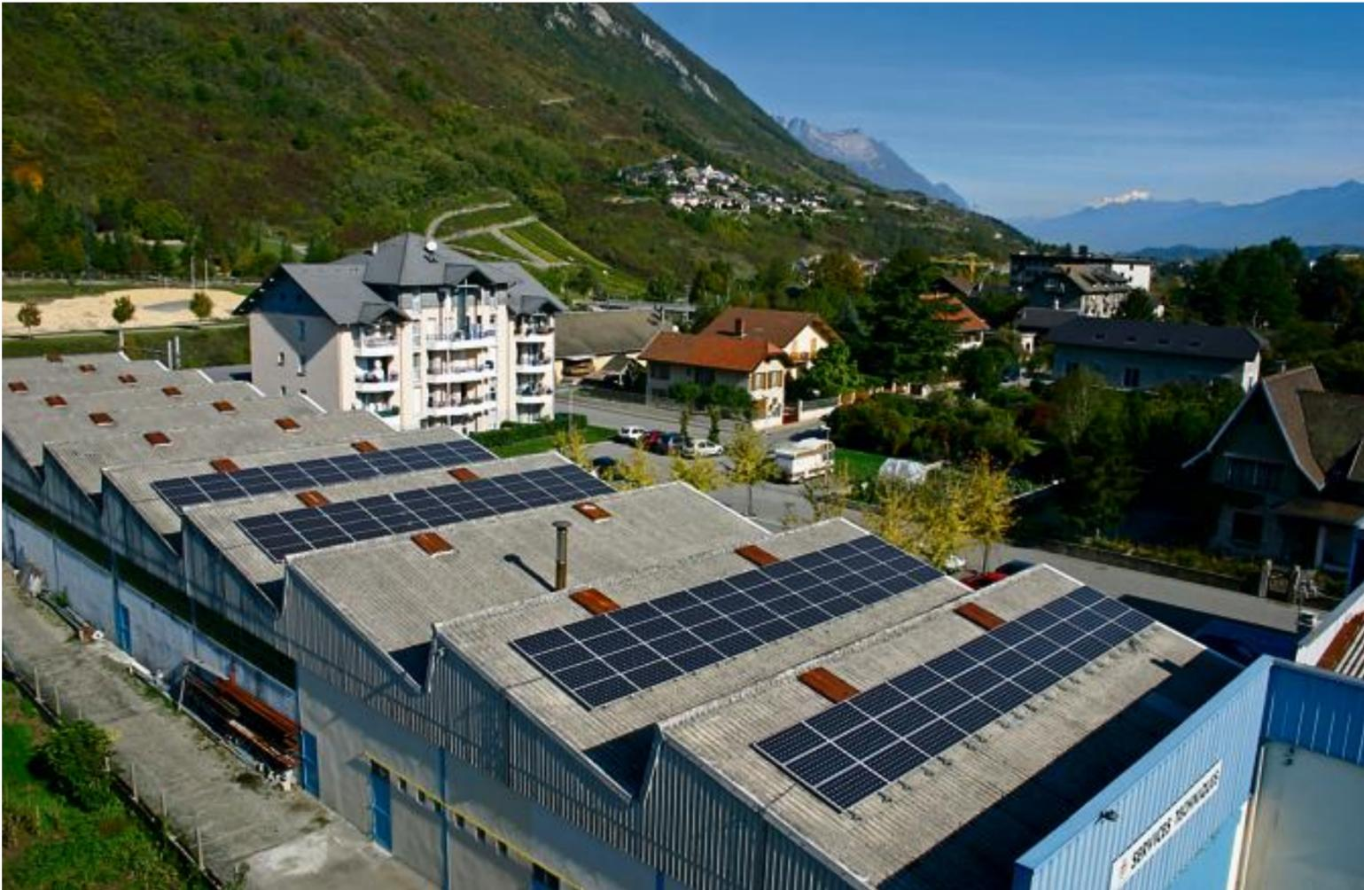
La toiture des ateliers municipaux est couverte de 240 m<sup>2</sup> de panneaux photovoltaïques, qui produisent l'équivalent de la consommation des services techniques de la ville et des quatre véhicules électriques municipaux.
