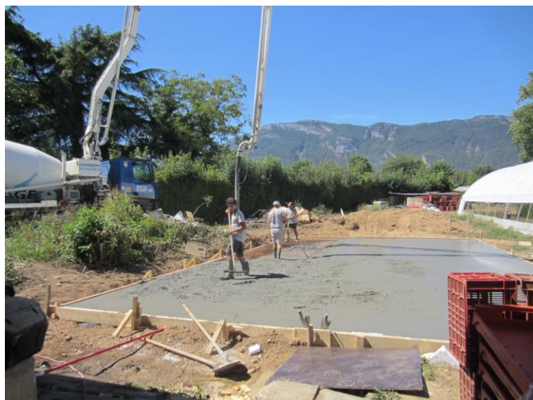
Le coulage de la dalle s'achève
