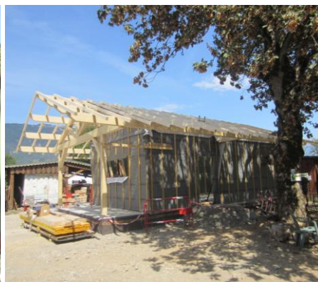
La charpente quasiment finie
