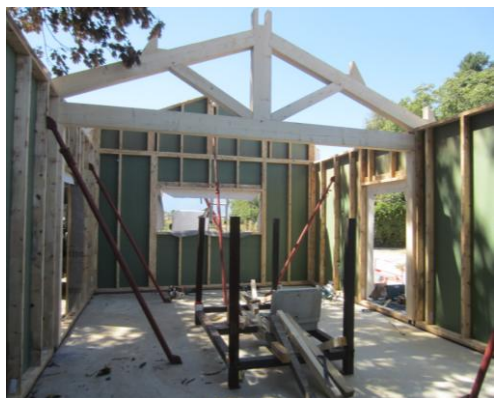
Les murs, vus de l'intérieur
