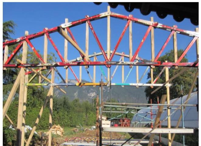
La charpente de protection de la nouvelle chambre froide, à base de skis réformés, commence à prendre forme.
