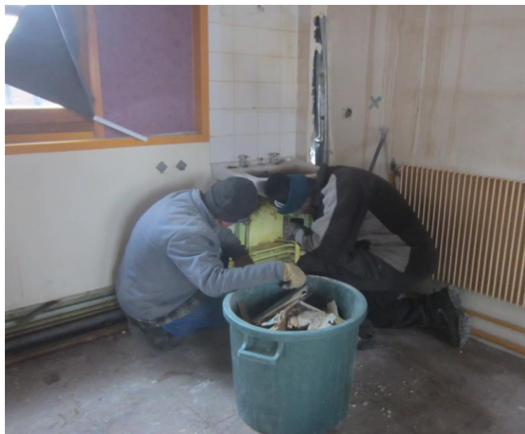
Denis et Alain en plein travaux de plomberie
